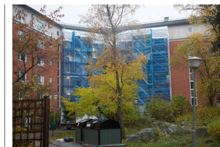
Full fart på renoveringen vid Örnens väg. I april kan vi se resultatet!
